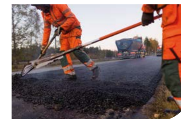
Matériaux de construction et asphalte
